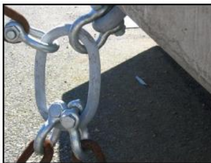
Figur 9. Förankringsbyglar och "bridlering" kopplar samman kättinglängderna på piren.
