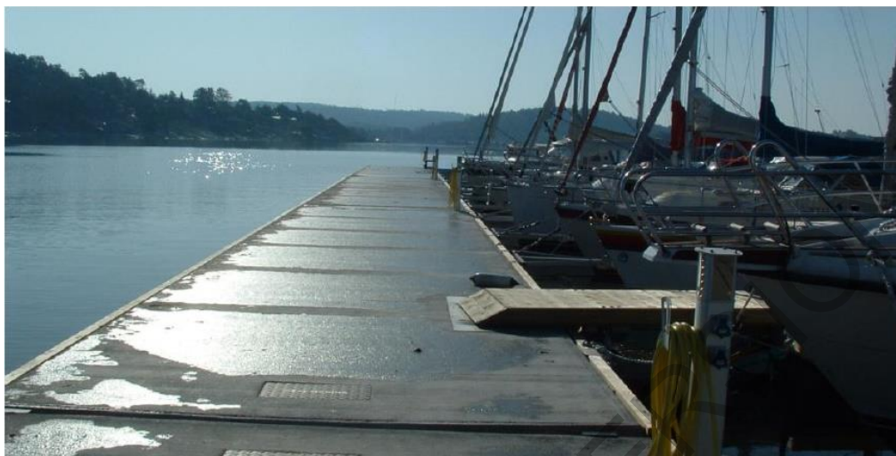
Figur 7. Exempel på betongponton.
